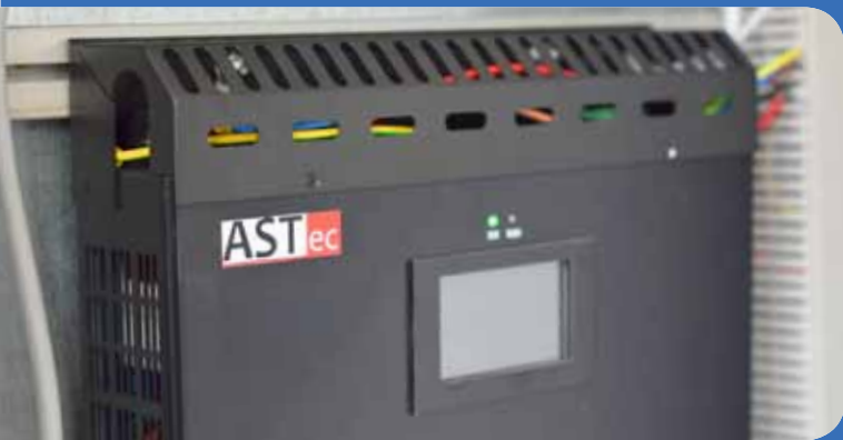
Rysunek 7. Wygląd zewnętrzny Statycznego Generатора Mocy Biernej SVG o mocy 25 kVar
